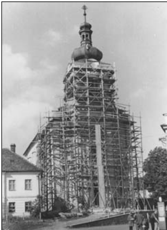
Kostel před opravou - srpen 1966
